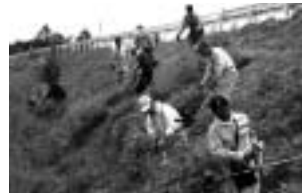
草刈機で除草作業
