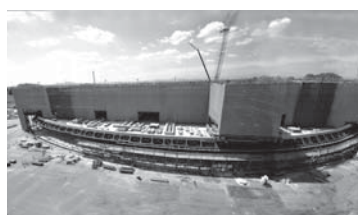
工事現場の様子
