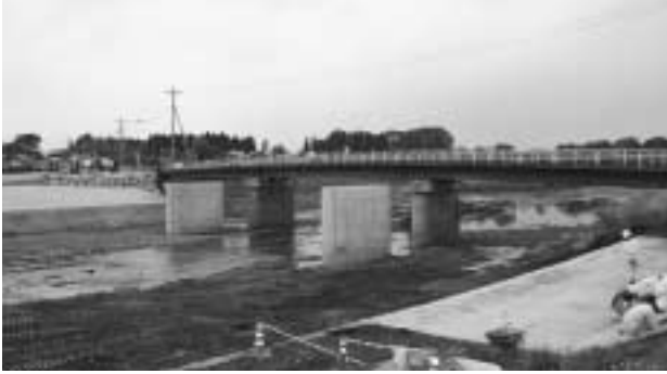
建設中の箕輪橋（姿川）
