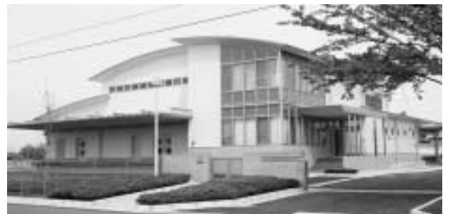
学校給食センター (下野市小金井)
