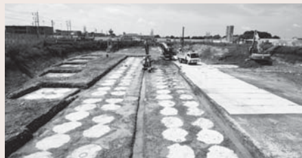
地盤改良工事の様子
