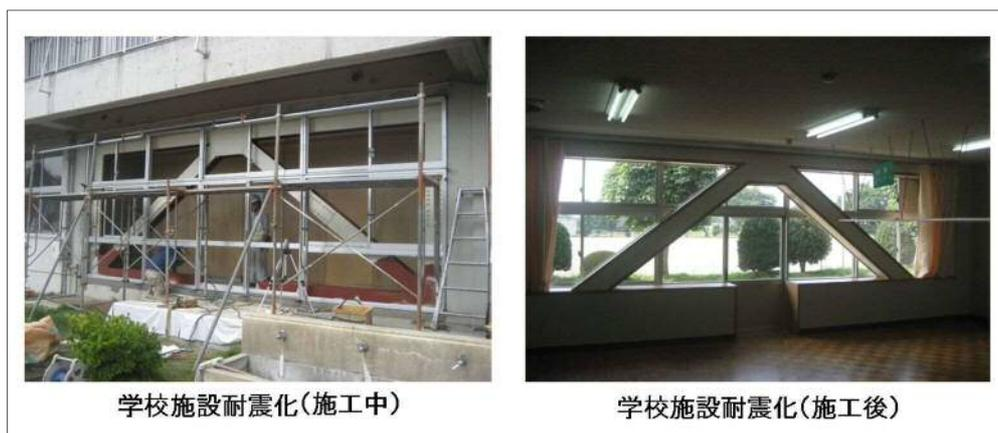
図 2-10 耐震性向上の施工（公共施設の例）
