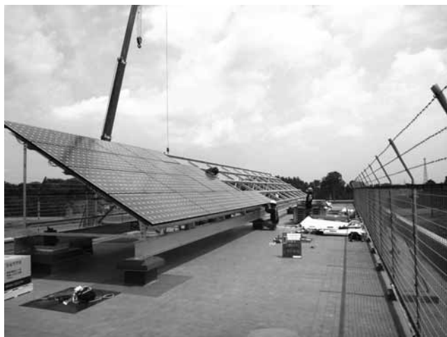
国分寺東小学校太陽光発電装置設置工事
