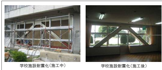
【耐震性向上の施工（公共施設の例）】
