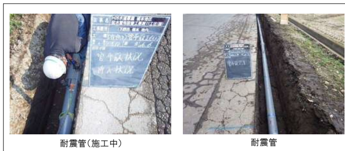
【耐震性向上の施工（都市基盤施設の例）】
