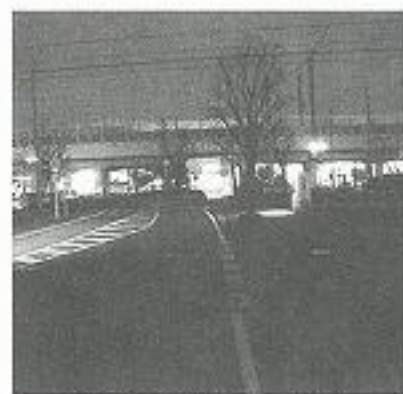
自治医大駅西口広場
