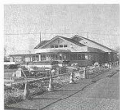
建設がすすむ友愛館
