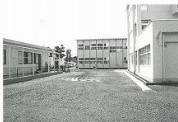
石橋小の学童保育室(左)と耐震補強等工事現場(中央、右)
