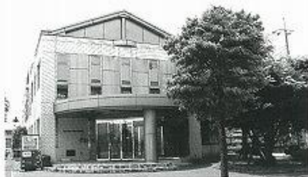
生涯学習情報センターと祇園小学児童保育室が入る旧下水道組合庁舎
