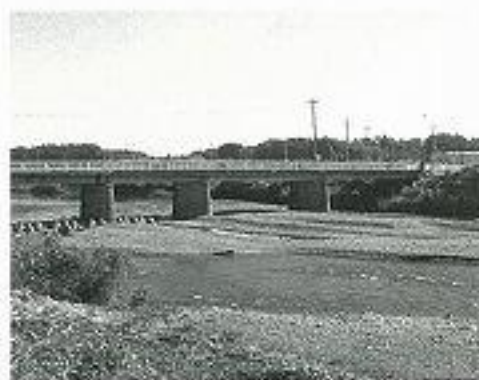
改修された長田橋（一部通行止め）
