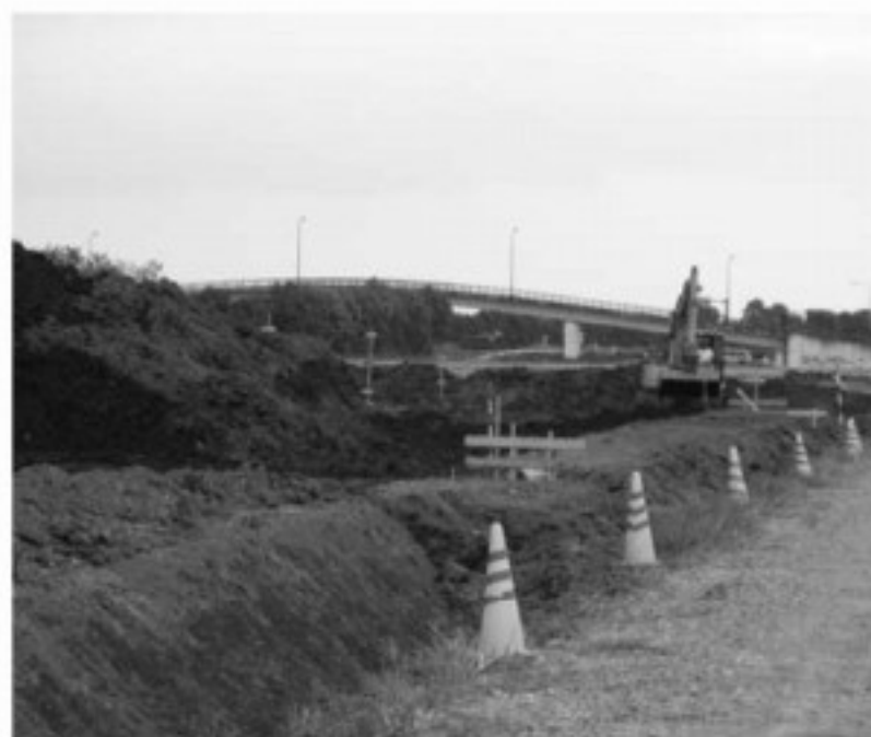
▲敷地造成工事が始まった道の駅
