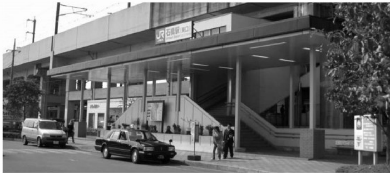
▲エレベータが設置されるJR石橋駅東口（石橋駅バリアフリー整備事業）
