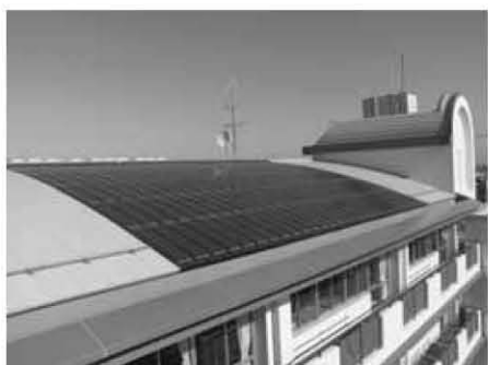
▲小中学校3校に太陽光発電装置を設置
