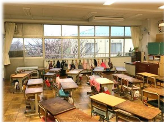
小学校空調設備設置
