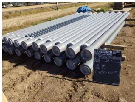
ダクティル鑄鉄管 (GX型)
