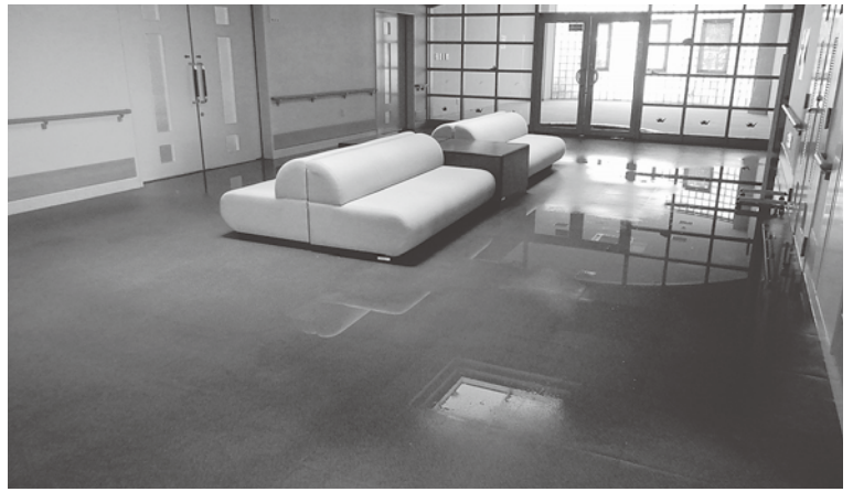
浸水したきらら館のロビー
