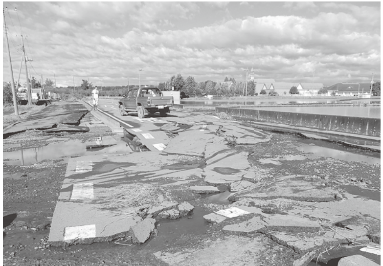
ひび割れた市道2081号線
