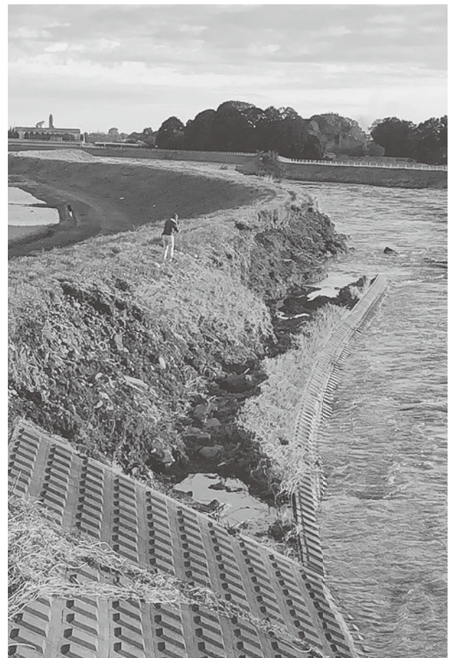
堤防が崩壊した田川左岸
