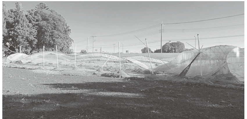
崩れたトマトのハウス
