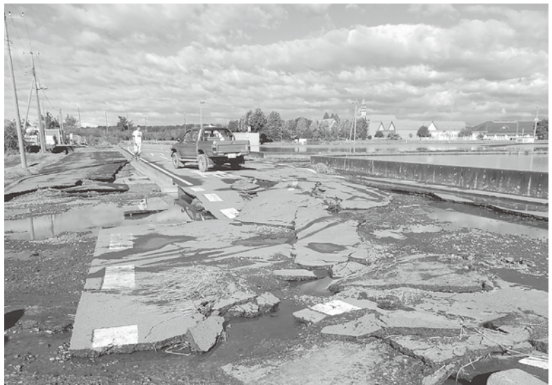
ひび割れた市道2081号線
