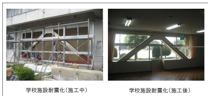
【耐震性向上の施工（公共施設の例）】
