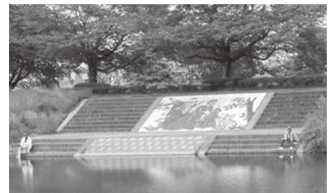
姿川護岸の化粧ブロック
