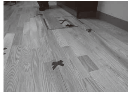
床板の浮きが発生した箇所
