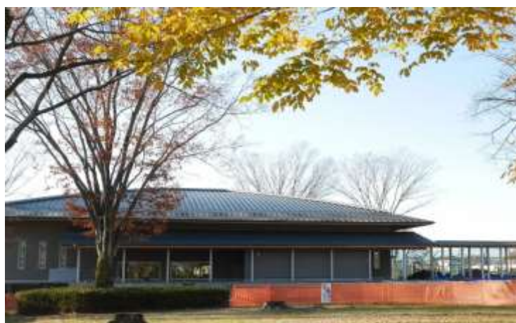
しもつけ風土記の丘資料館増築工事（東から）
