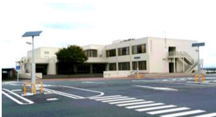
大規模改修した国分寺公民館
