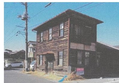
調査により把握された建造物② (石橋地区)
