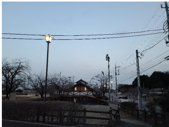
花広場照明LED化改修工事
