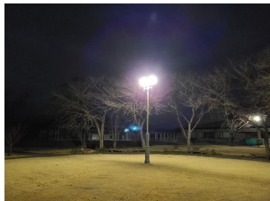
レストハウス北側広場LED改修工事
