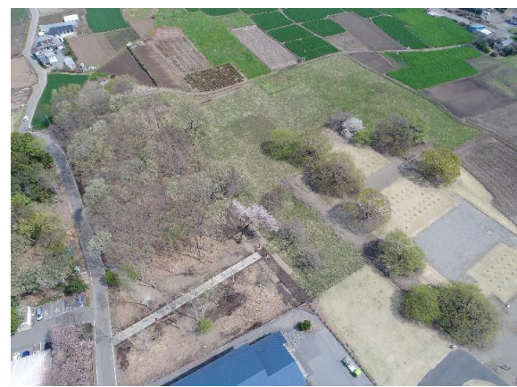
下野国分尼寺跡第2期整備事業竣工写真
