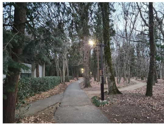
防人街道照明LED化改修工事
