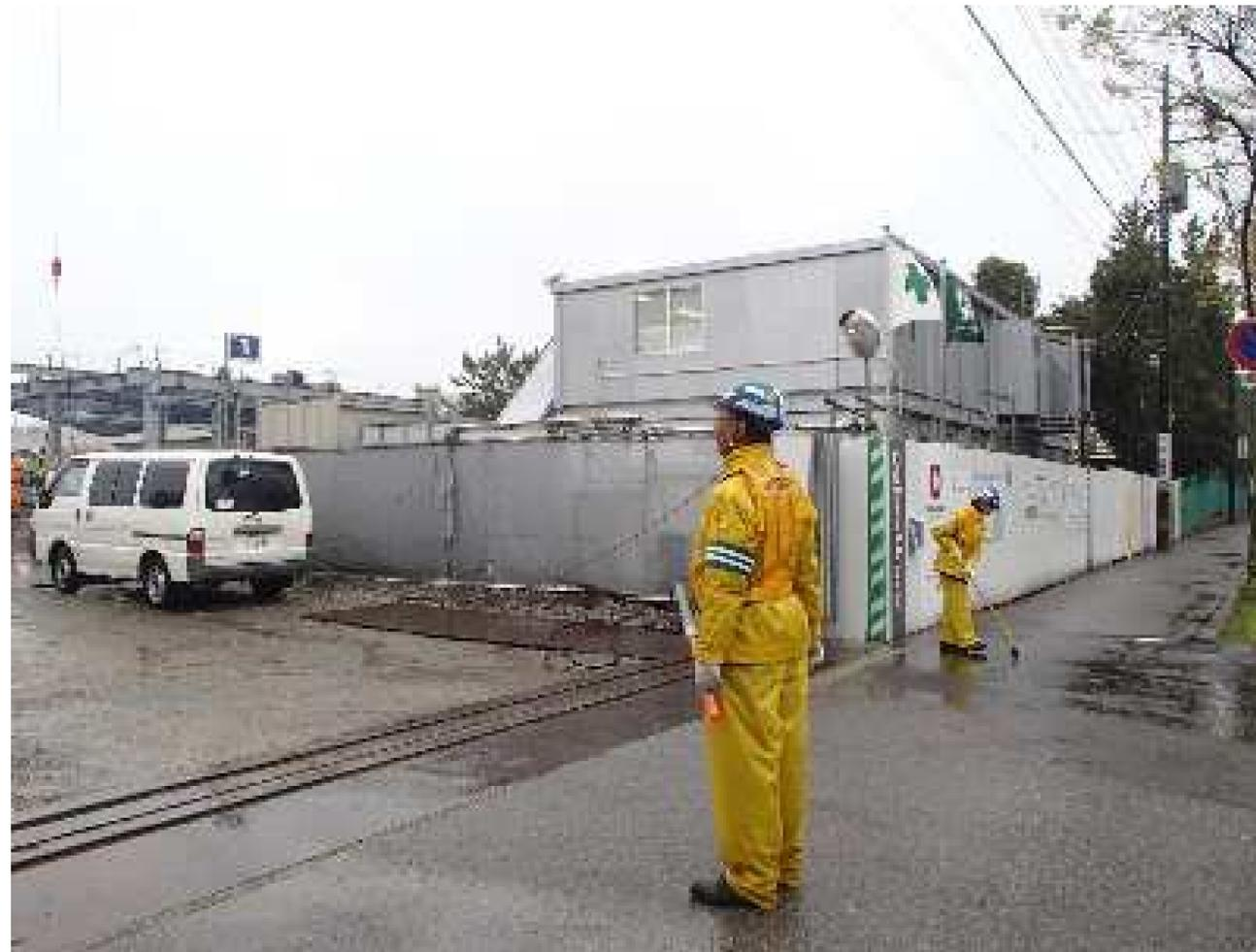
工事車両の搬出入は**第1・2ゲート**から行います。第3ゲートに関しては第1・2ゲートが使用できない場合また小物の搬出入時に使用します。ゲート前には警備員を常駐配備し、歩行者・工場内車輛優先の交通誘導を行います。
