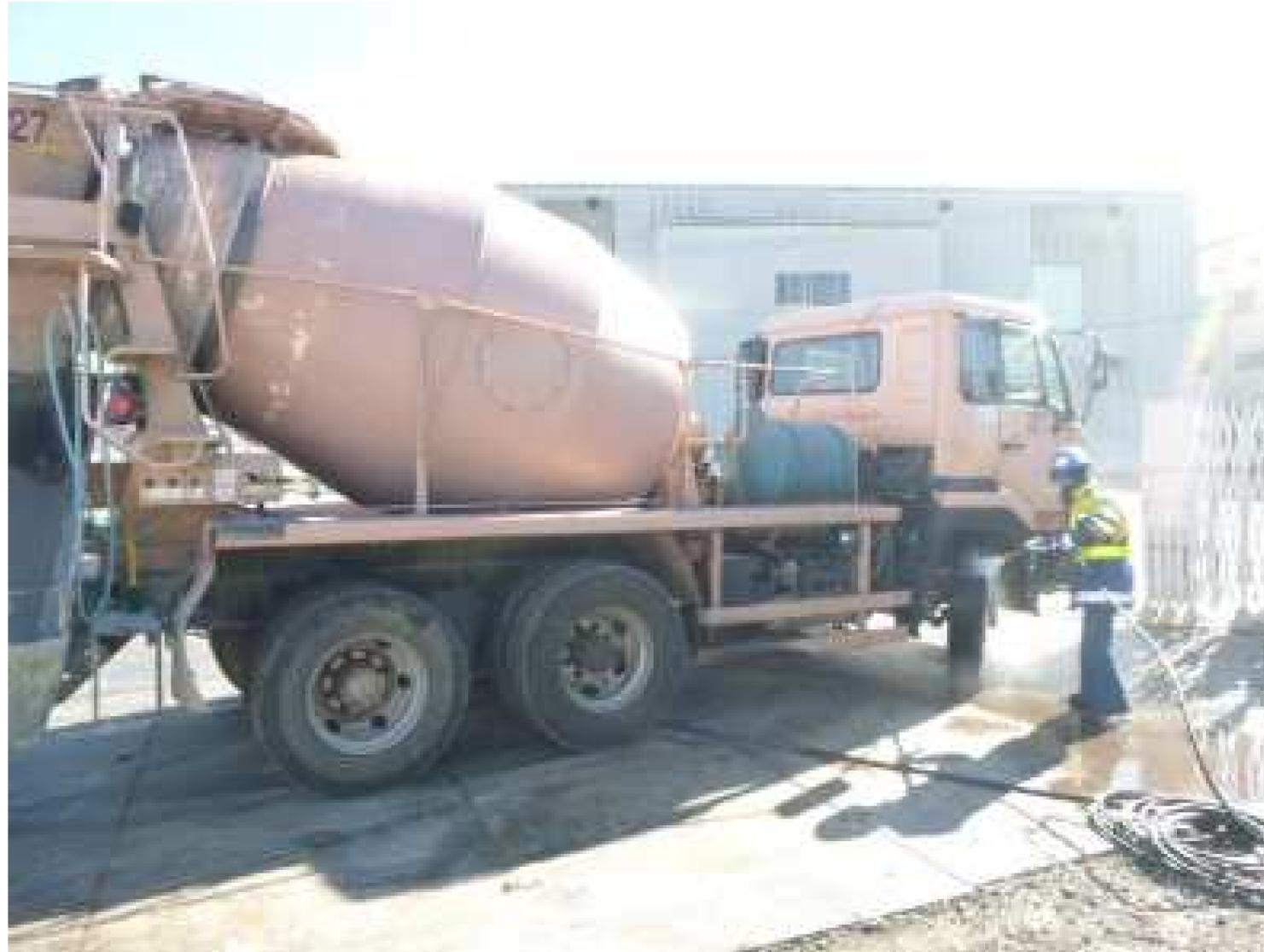
工事車両出場時のタイヤ洗浄および前面道路への散水を適宜行い、現場内及び現場周辺道路の美化・砂塵発生防止に努めます。
