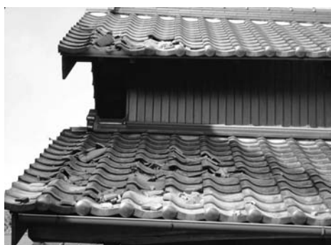
損害を受けた家屋の屋根瓦
