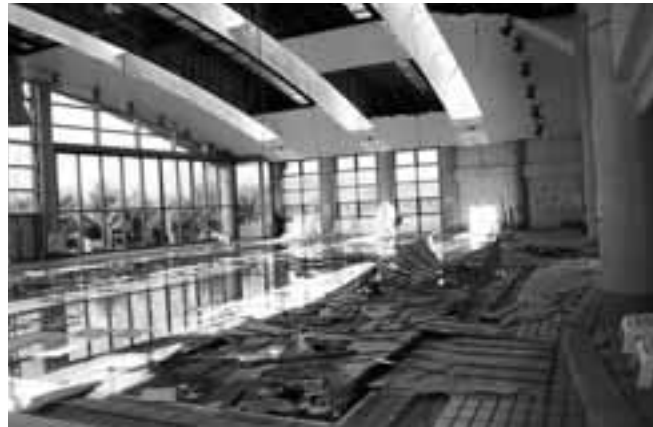
プールの天井が崩落したふれあい館
