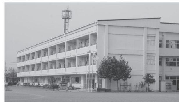
石橋小学校改修事業
