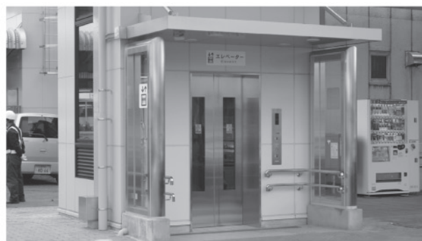
石橋駅西口エレベーター
