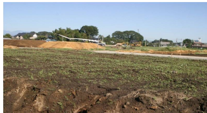
敷地造成工事
