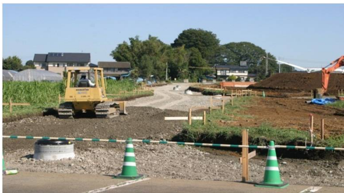
周辺道路整備工事
