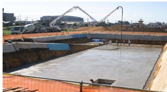
雨水貯留施設整備工事
