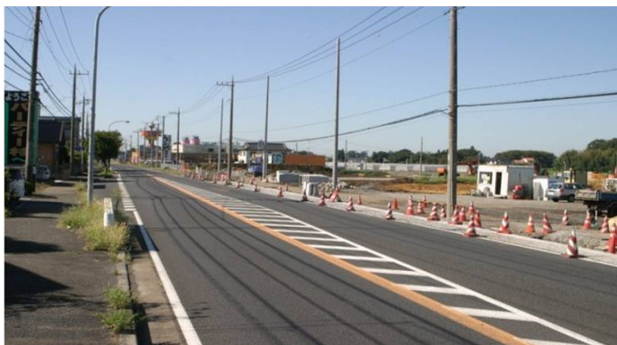
国道 4 号交差点設置工事
