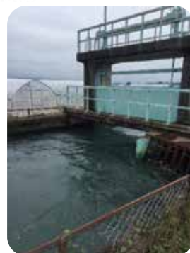
現在の取水口（真岡市）
