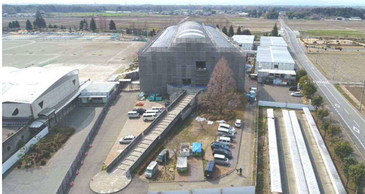
石橋中学校大規模改修工事
