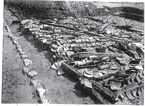
9、山田寺東回廊倒壊・瓦落下状況
