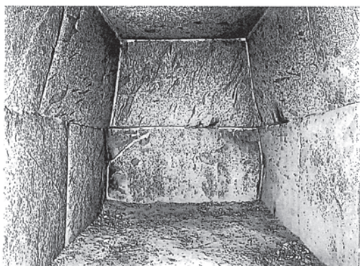
13、岩屋山古墳の切石積み石室
