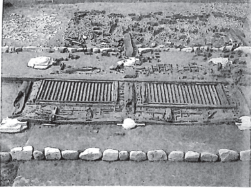
8、山田寺東回廊倒壊状況
