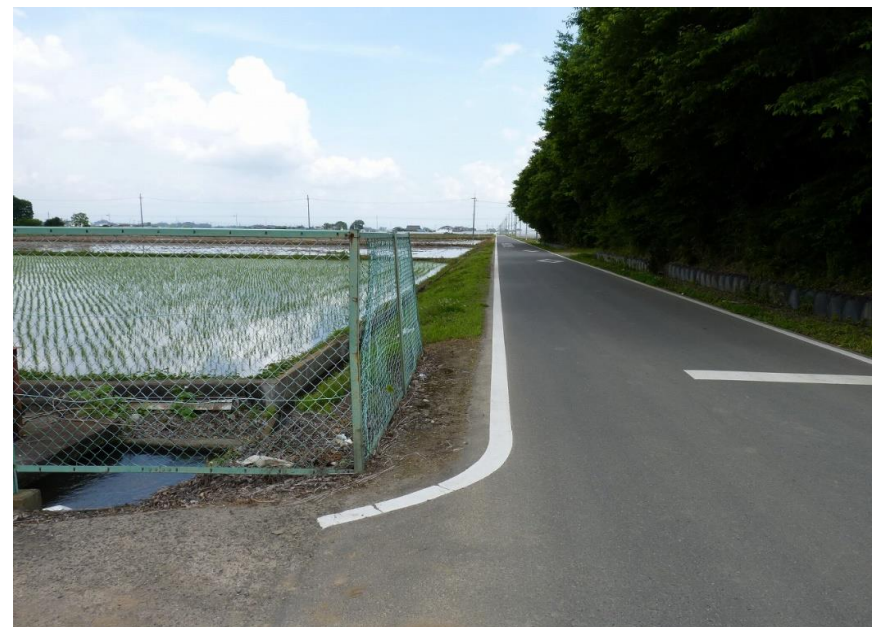
用水路転落防止の金網柵。
