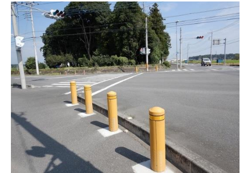
通学路交差点に防護柵を設置
