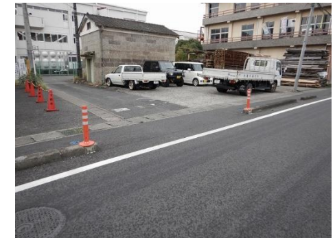
歩車道境界にラバーポールを設置
