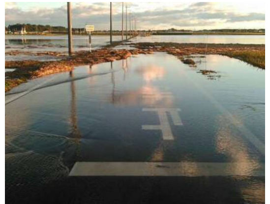
令和元年東日本台風による市内浸水被害状況
