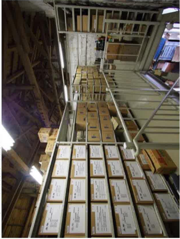
第 1-11 写真 倉庫南側 2 階内観 1
