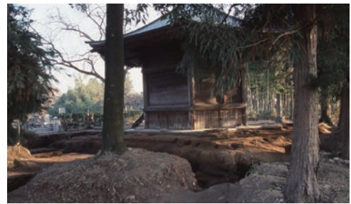
西金堂の調査（北西から）
