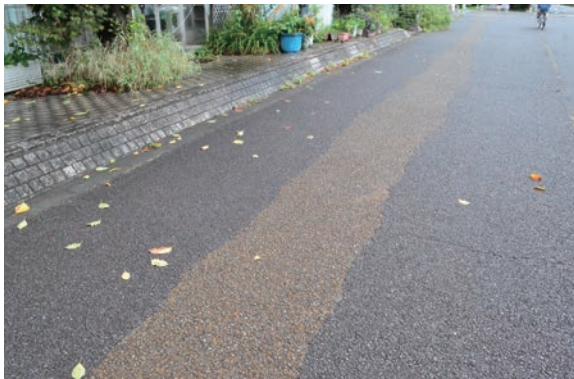
カラー舗装の整備例（東山道武蔵路）
