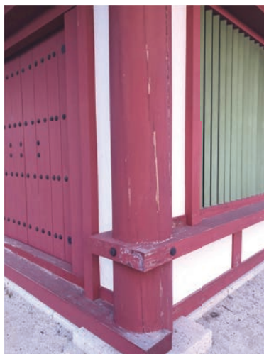
柱のひび割れや塗装の色落ち
