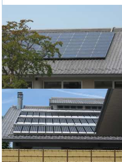
下野市保健福祉センター「ゆうゆう館」の太陽光発電・太陽熱温水器の活用
