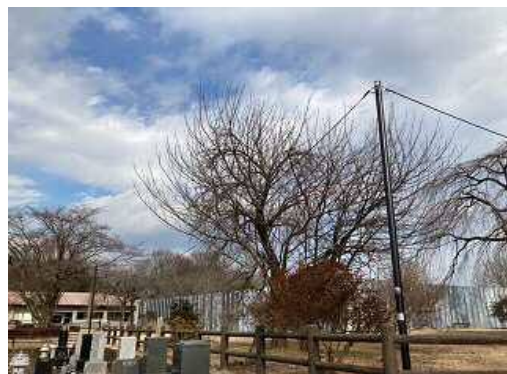
放送設備配線改修工事
