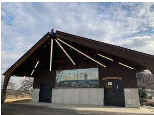
ステージ照明改修工事
