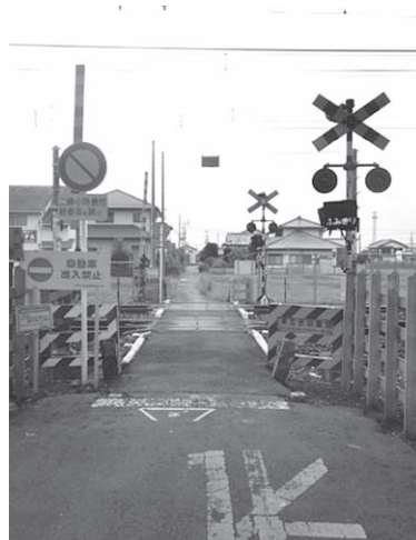
第五多功踏切(東側から)
